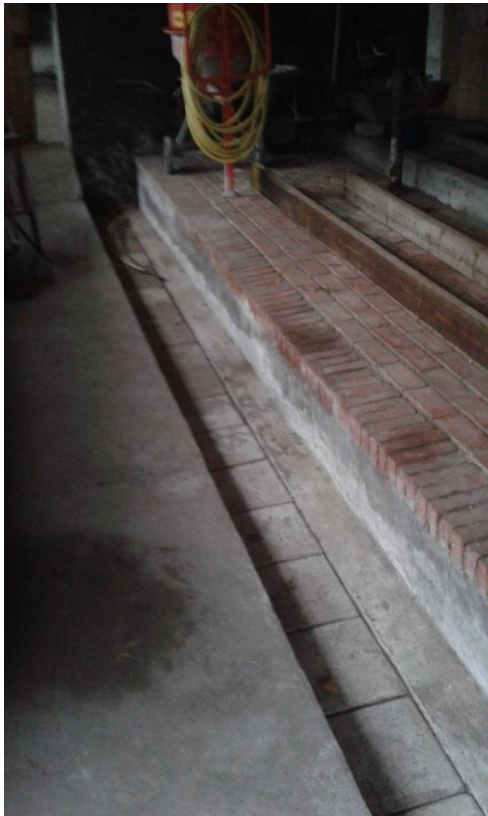
Afbeelding 11. Bovenzijde van de voormalige giergoot in de jongveestal.
